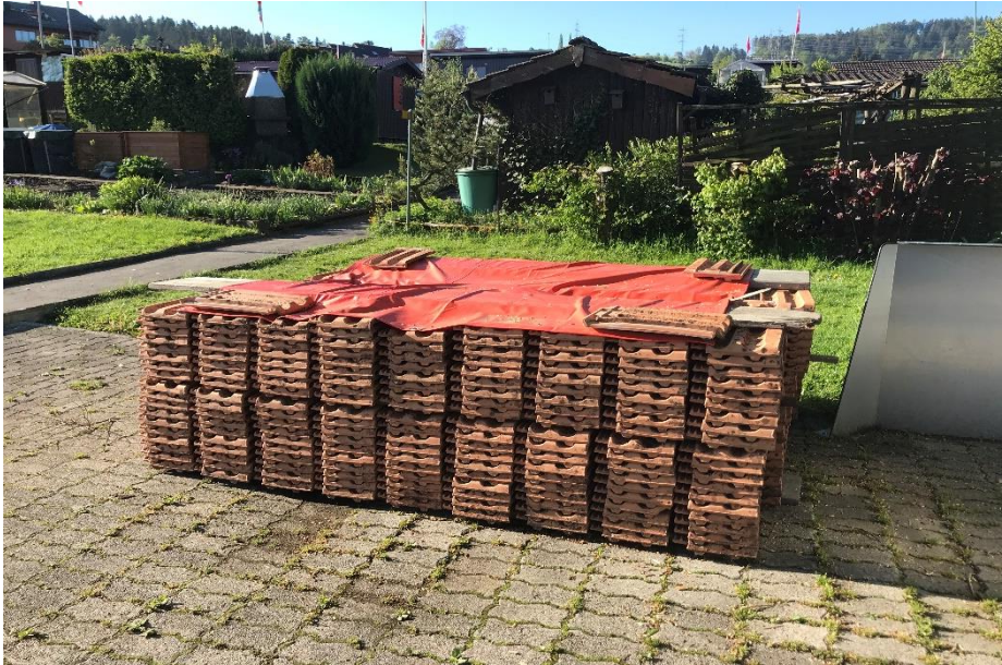
Neue Ziegel für Dacherneuerung 2020
